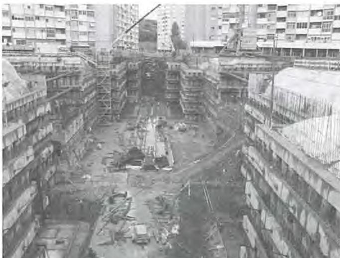
Figura 5.4 - Vista geral da contenção. Quatro níveis de ancoragem e a proximidade dos edifícios.
