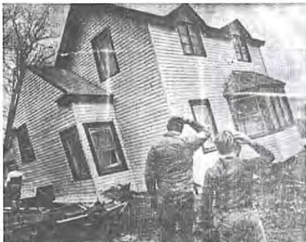
Figura 2.14 – Danos numa edificação devido à ruptura da fundação
